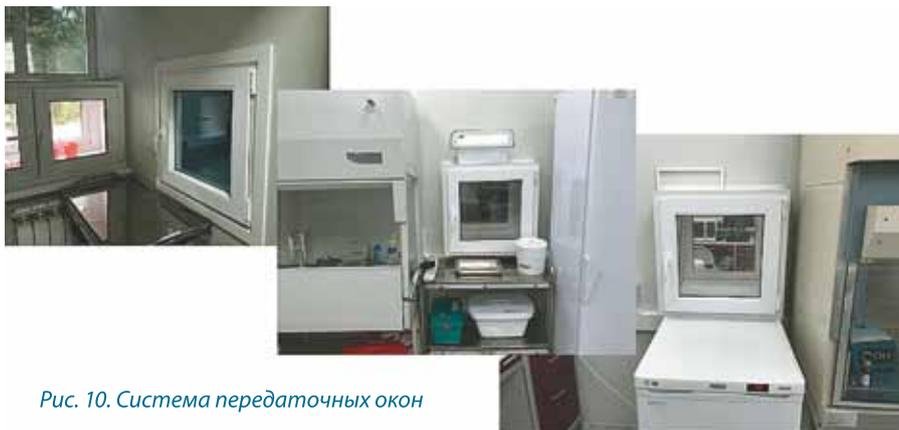
Рис. 10. Система передачочных окон
